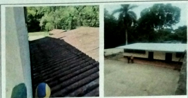
Foto 13: MODULO B AULA Sustitucion de cubierta de asbesto en mal estado y se coloco estructura de metal a base de costaneras de metal.
