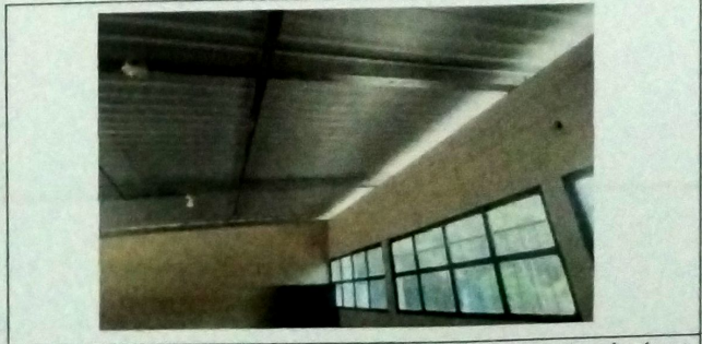
Foto 17: MODULO B Interior de aula Sustitucion de cubierta de asbesto en mal estado y se coloco estructura de metal a base de costaneras de metal.
