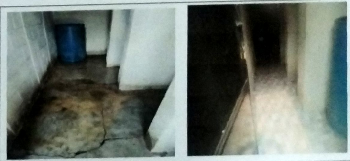
Foto 4: VISTA MODULO D SERVICIOS SANITARIOS Suministro e instalacion de piso ceramico.
