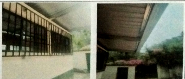
Foto 12: MODULO A Balcones en vanos de aulas y vista corredor donde se cambio cubierta de asbesto por lamina troquelada cal 26.
