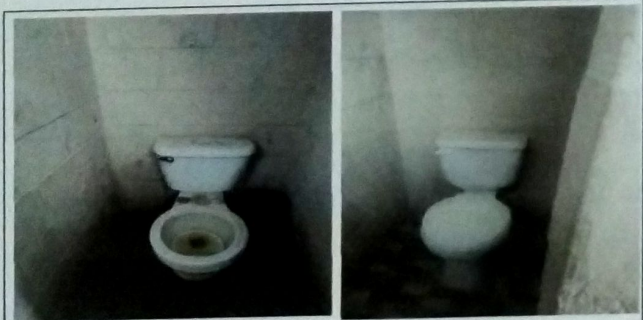
Foto 3: VISTA MODULO D SERVICIOS SANITARIOS Sustitucion de sanitarios en mal estado
