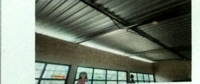
Foto 16: MODULO B AULA Interior de aula Sustitucion de cubierta de asbesto en mal estado y se coloco estructura de metal a base de costaneras de metal.
