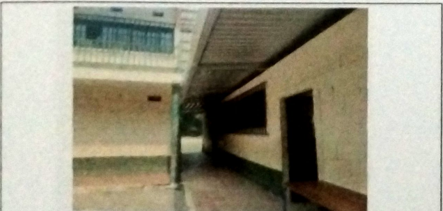
Foto 11: MODULO A Corredor Sustitucion de cubierta de asbesto en mal estado y se coloco estructura de metal a base de costaneras de metal.
