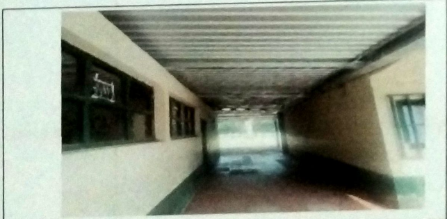
Foto 15: MODULO B CORREDOR Sustitucion de cubierta de asbesto en mal estado y se coloco estructura de metal a base de costaneras de metal.
