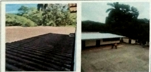
Foto 9: MODULO A AULA Sustitucion de cubierta de asbesto en mal estado y se coloco estructura de metal a base de costaneras de metal.
